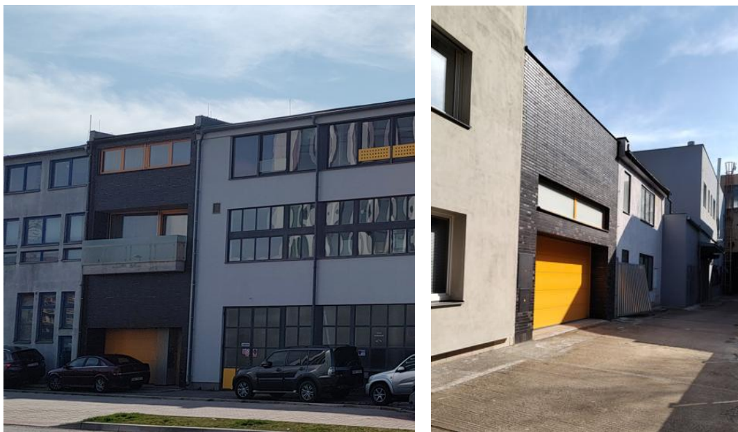
Pohled na budovu
